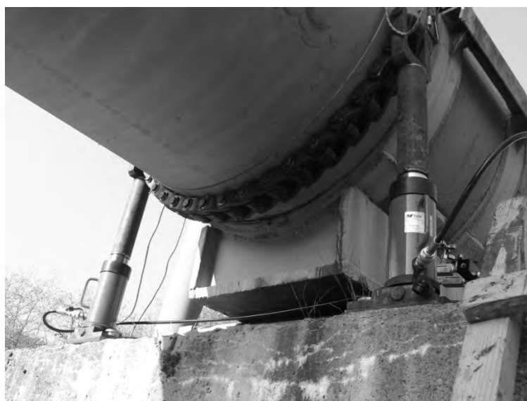
Рис. 1. Пристрій для піднімання трубопроводів великого діаметра
