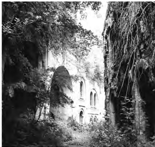
Рис. 6. Полігональна вулиця, що розмежовує бічні каземати і будівлю центральних казематів. Центральна казарма (праворуч), каземати (ліворуч)
