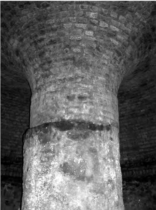
Рис. 18. Фрагменти несучої конструкції центральної казарми
