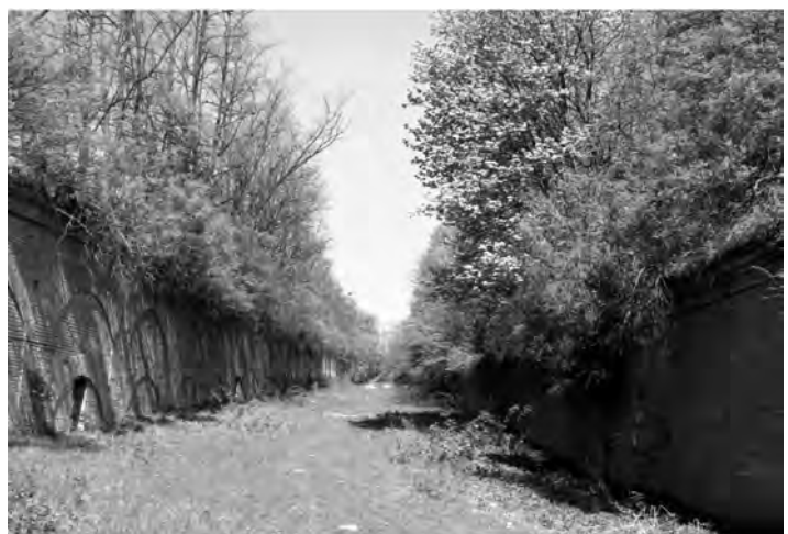
Рис. 7. Сухий рів форту. Загальний вигляд північно-східного рову. Ескарпова і контрескарпова стіни
