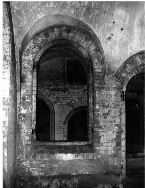
Рис. 11. Розподільчі коридори центральної казарми.
