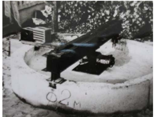
Рис. 2. Загальний вигляд лотка для випробувань моделей куцців висячих паль
