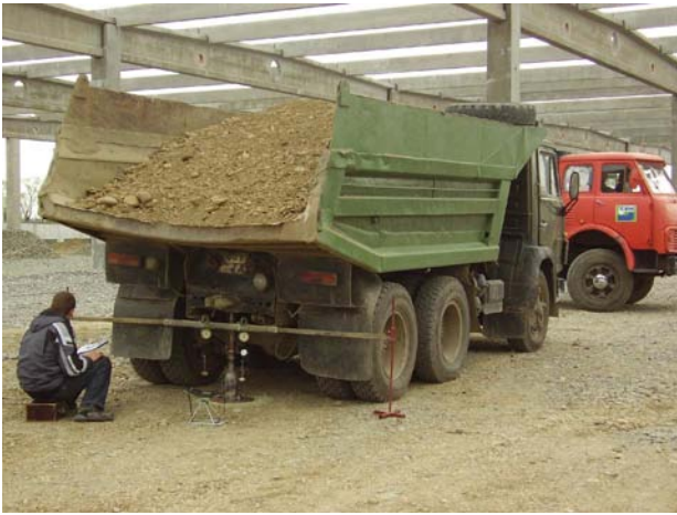
Фото 2. Діагностика технічного стану конструкції штучної основи
