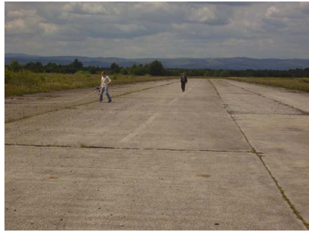
Фото 3. Ведуться роботи з технічної експертизи аеродромного покриття
