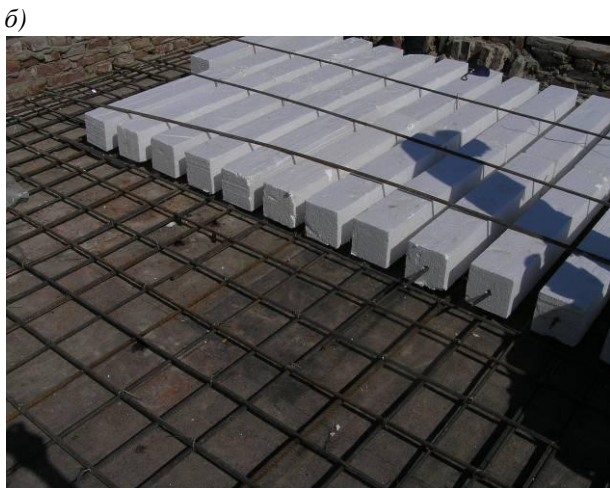
Рис. 6. Плоске монолітне залізобетонне перекриття розмірами в плані 7,6 \times 12,1 м з вставками: а – загальне конструктивне рішення перекриття (1 – муровані стіни; 2 – монолітний залізобетон; 3 – вставки з пінополістиролу); б – розкладання і фіксація вставок; в – бетонування перекриття
