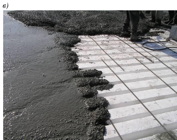
Рис. 6. Плоске монолітне залізобетонне перекриття розмірами в плані 7,6 \times 12,1 м з вставками: а – загальне конструктивне рішення перекриття (1 – муровані стіни; 2 – монолітний залізобетон; 3 – вставки з пінополістиролу); б – розкладання і фіксація вставок; в – бетонування перекриття
