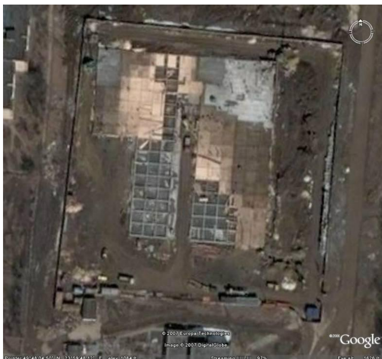
Рис. 2. Будівництво коробчатої монолітної плити фундаменту супермаркету «Арсен» по вул. Кн. Ольги
