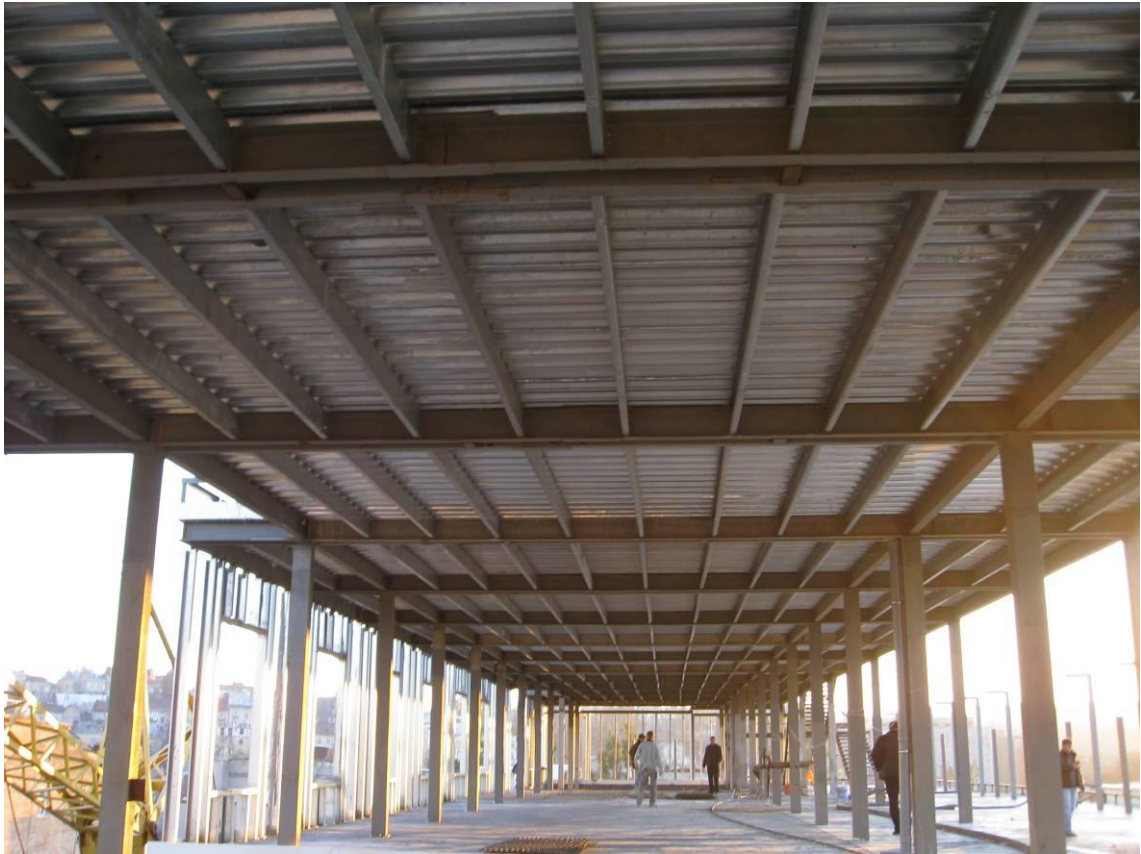
Рис. 1. Каркас надбудови офісного центру по пл. Петрушевича, 3
