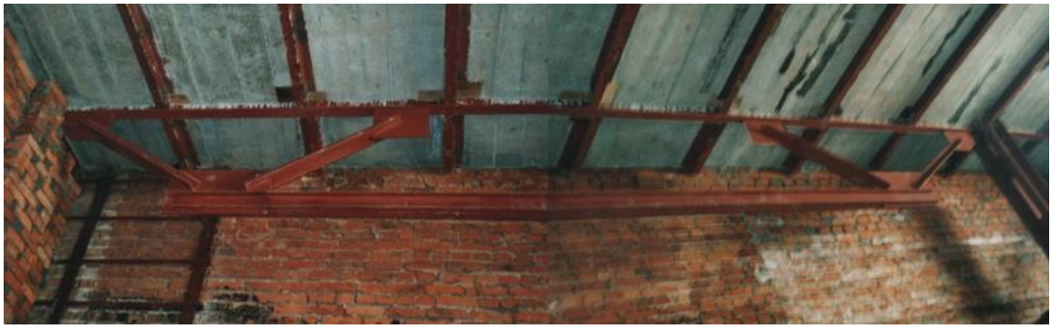
Рис. 7. Балко-ферми перекриття в складі монолітного залізобетонного перекриття
