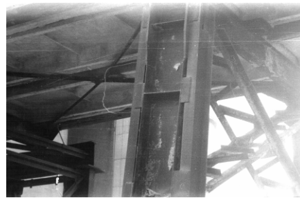
Рис. 9. Посилення колон цеху Калуського ВО "Нафтобурмаширемонт" регулюючими елементами з труб (м. Калуш, Івано-Франківської обл.)
