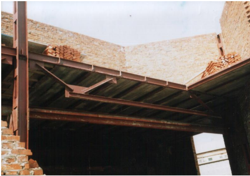
Рис. 6. Балко-ферма перекриття
