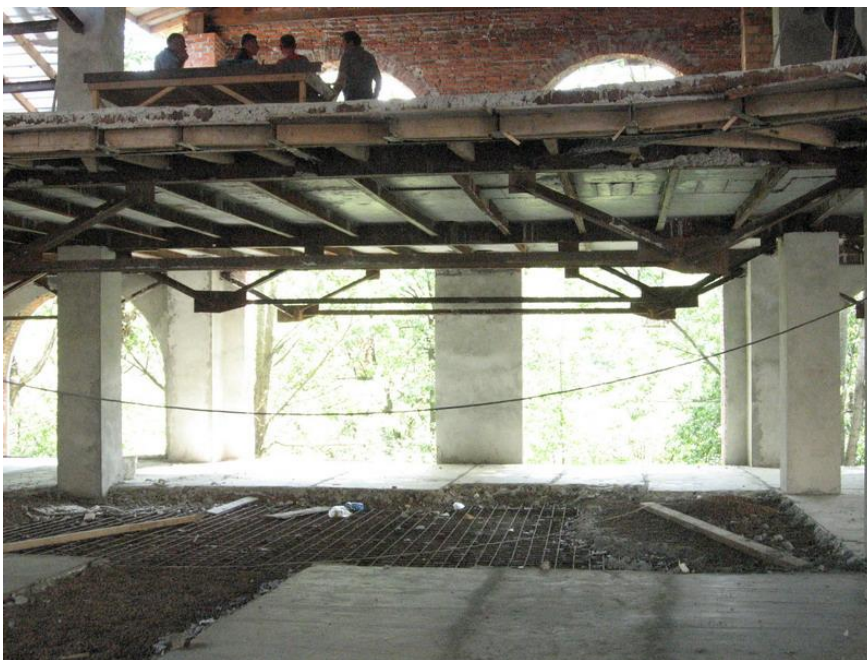
Рис. 7. Загальний вигляд балко-ферми перекриття під час будівництва
