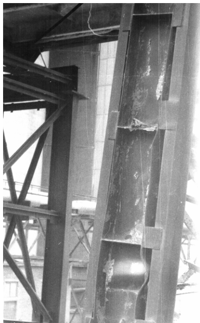
Рис. 10. Посилення сильно деформованих колон естакади Рівненського ВО "Азот" а, б, в – фрагменти
