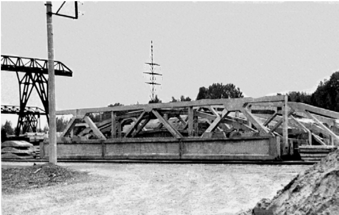
Рис. 51. Балки прогоном 18,0 м для збірно-монолітних нерозрізних конструкцій плоских покриттів (п. 13 в табл. 1)
