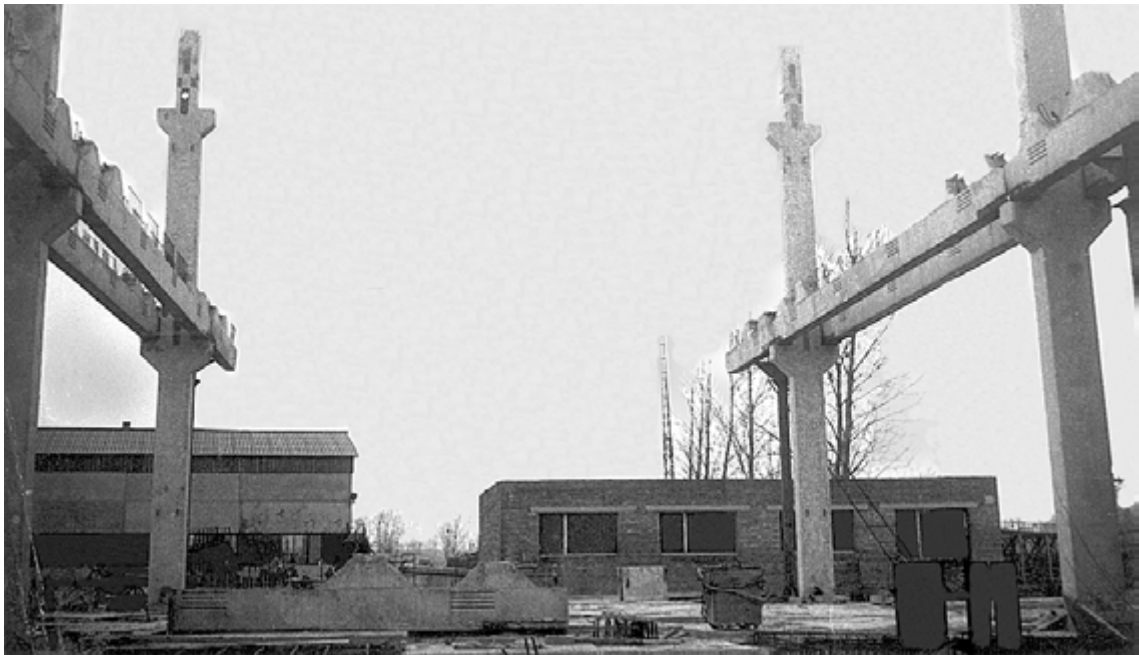
Рис. 53. Загальний вигляд дослідної конструкції каркаса багатопверхового будинку з сіткою колон 12 ´12 м у поздовжньому напрямі ригелів
