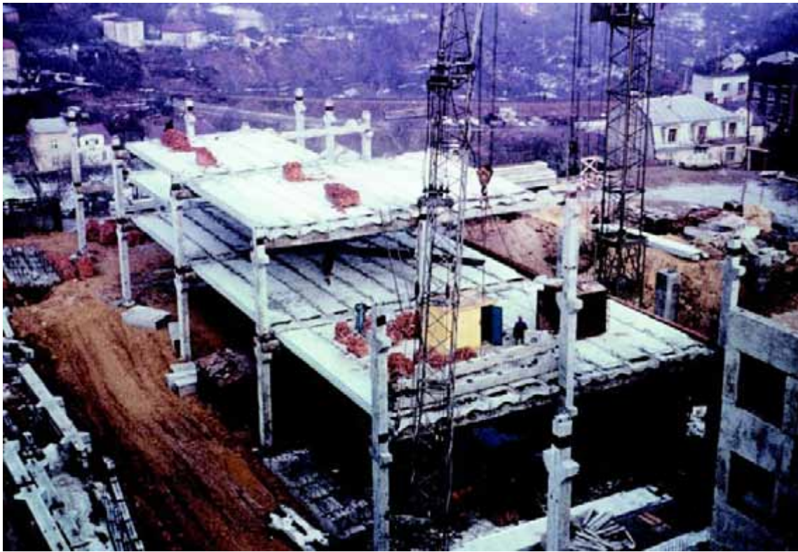
Рис. 21а. Монтаж елементів каркасів і перекриттів багатоповерхових будинків з сіткою колон 9 × 12 м (м. Львів, завод “Мікроприлад”)
