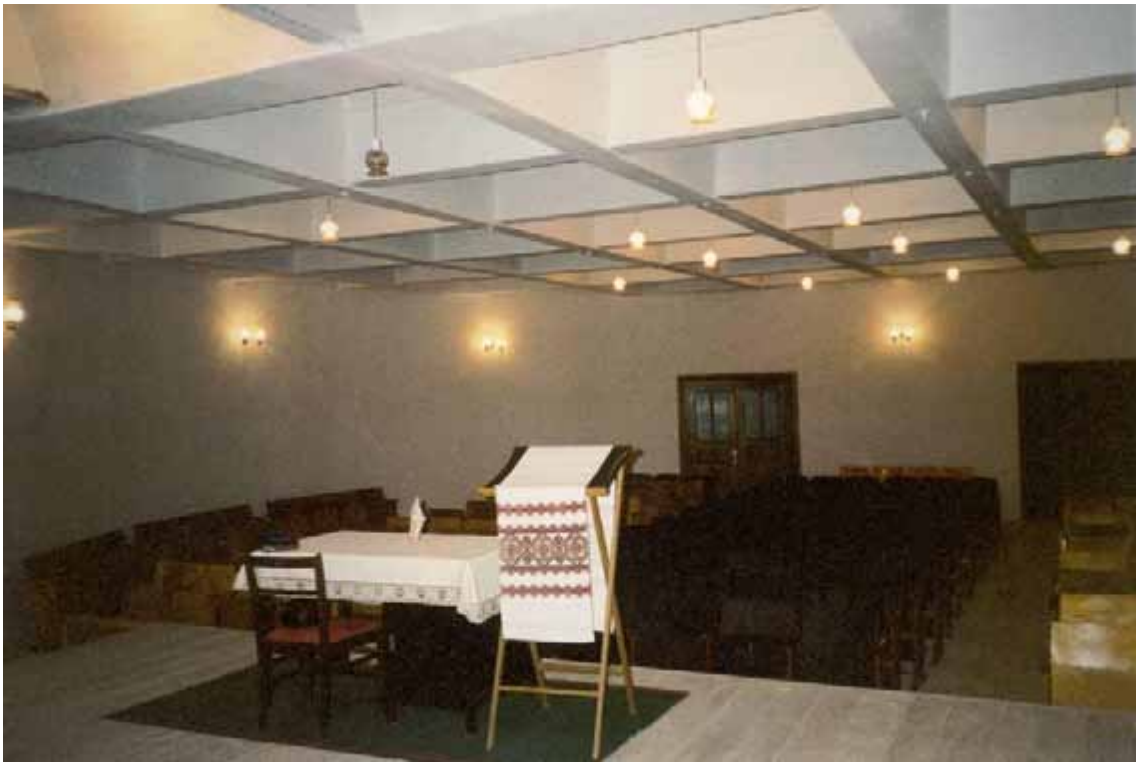
Рис. 22б. Збірно-монолітне нерозрізне перекриття цокольного поверху церкви Св. Володимира і Ольги (м. Львів)
