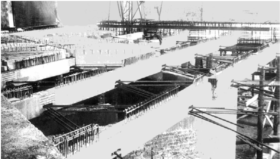
Рис. 56. Монтаж ЗМКП з трикутними кесонами непрямокутної форми для великих навантажень (м. Львів, стилобат адміністративного будинку по вул. Стрийській)
