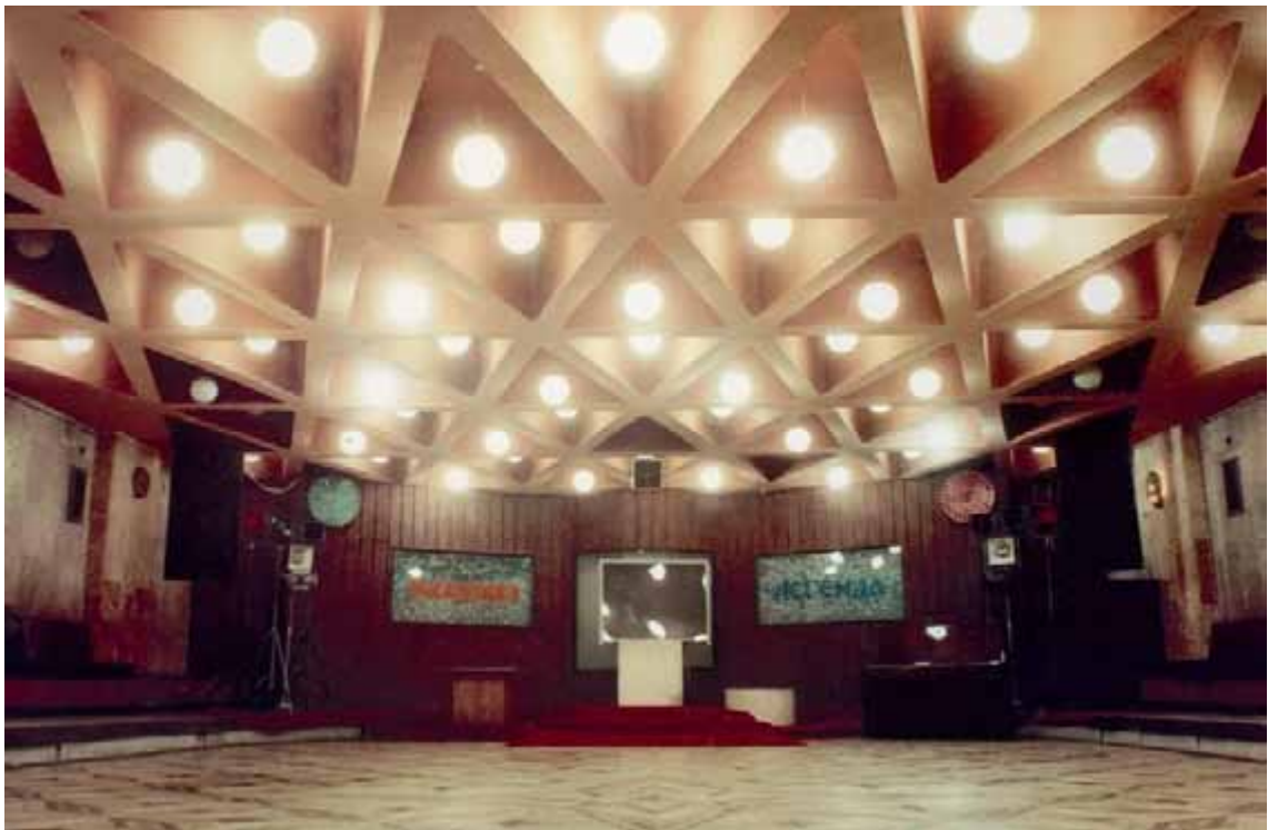
Рис. 15. Збірно-монолітне кесонне перекриття залу Будинку культури з трикутними кесонами розмірами 12 × 20 м (м. Львів, будинок культури ім. Г. Хоткевича)
