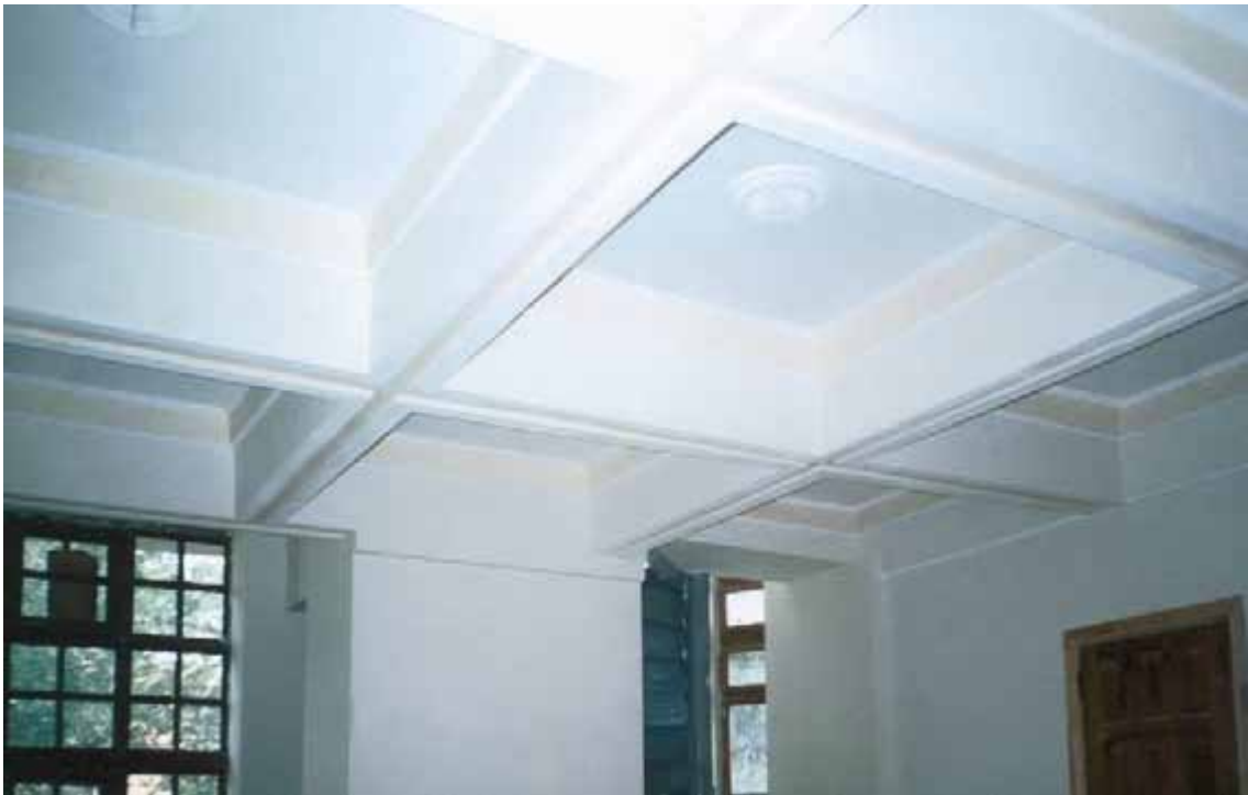
Рис. 23. Збірно-монолітне сталезалізобетонне кесонне перекриття житлового будинку (м. Львів)
