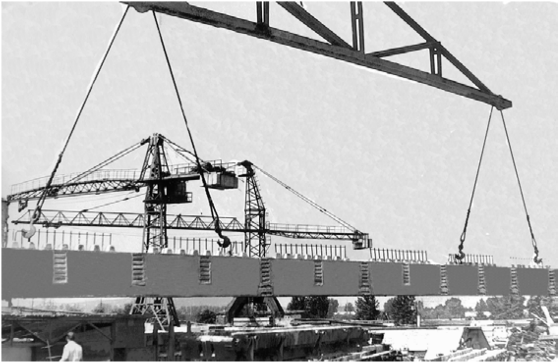
Рис. 54. Збірні попередньо-напружені балки прогоном 18,0 м для збірно-монолітних кесонних перекриттів, виготовлених стендовим способом (м. Львів, завод ЗБК № 2)
