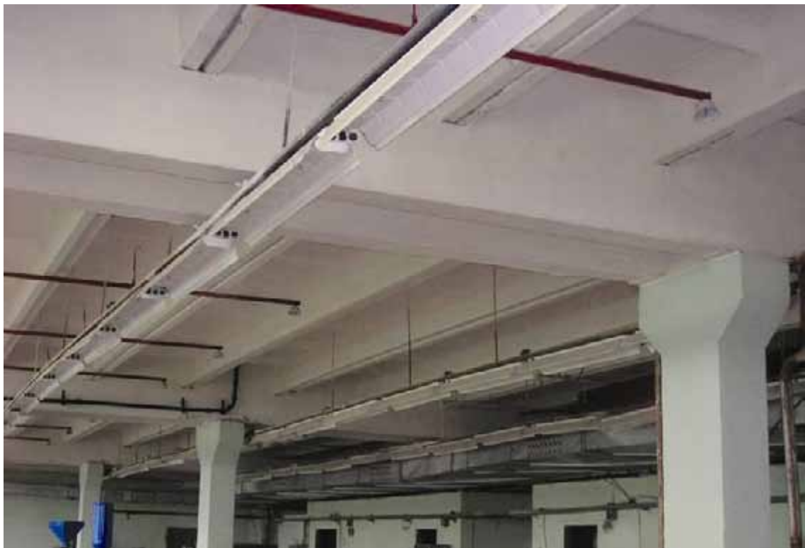
Рис. 21б. Загальний вигляд дослідних каркасів і перекриттів багатоповерхового будинку з сіткою колон 9 × 12 м у поперечному напрямі ригелів
