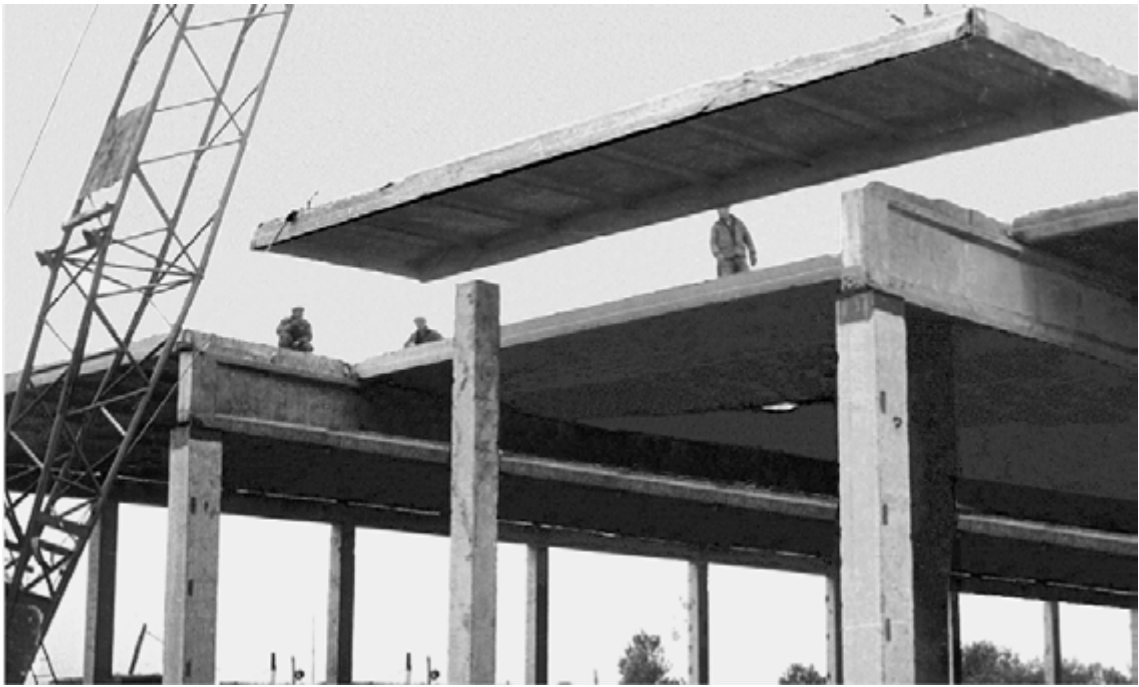
Рис. 52. Монтаж ребристых плит НПП-12 розмірами 12 ´3 м збірно-монолітних нерозрізних конструкцій покриттів будинків з сіткою колон 18 ´12 м (п. 31 в табл. 1)
