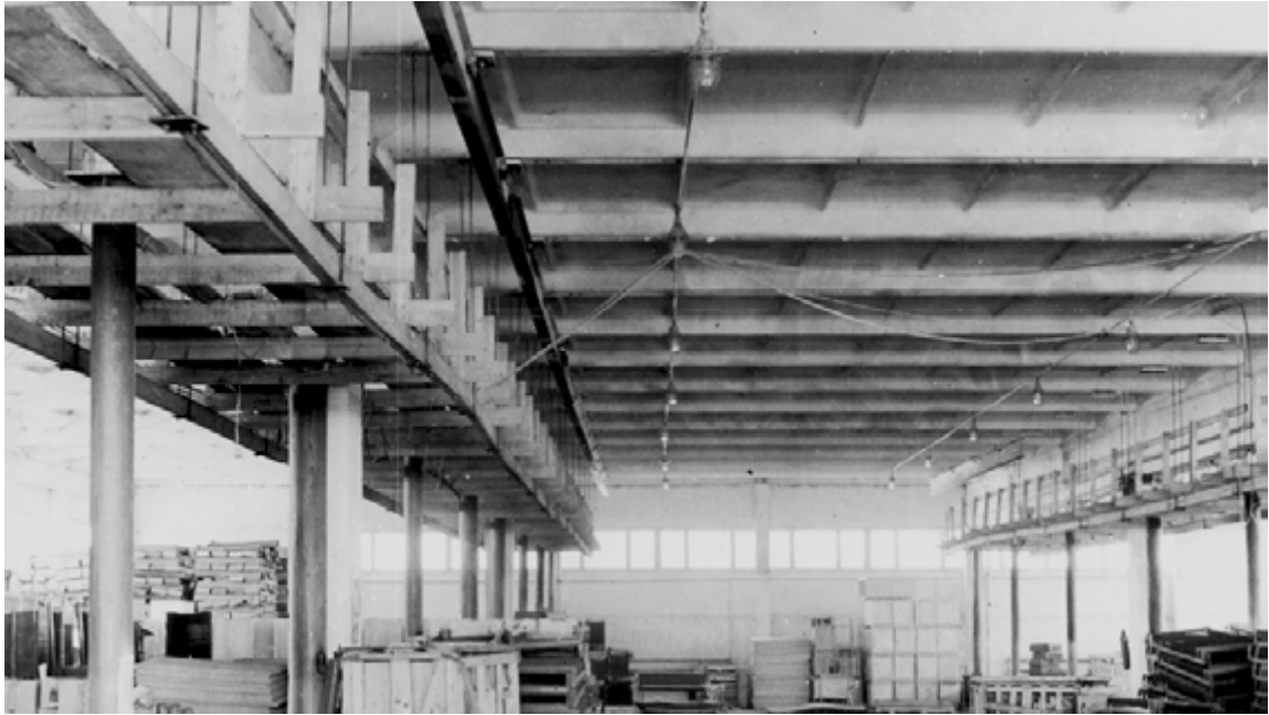
Рис. 48. Загальний вигляд довготривалих натурних випробувань збірно-монолітних конструкцій покриття з сіткою колон 18 × 12 м (п. 31 в табл. 1)
