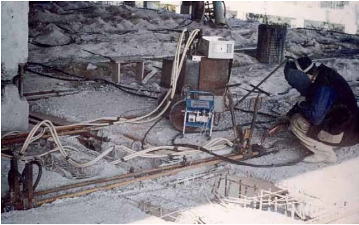
Рис. 21в. Натяг арматури стиків електротермічним методом з ванним зварюванням її до випусків з балок збірно-монолітного балкового перекриття
