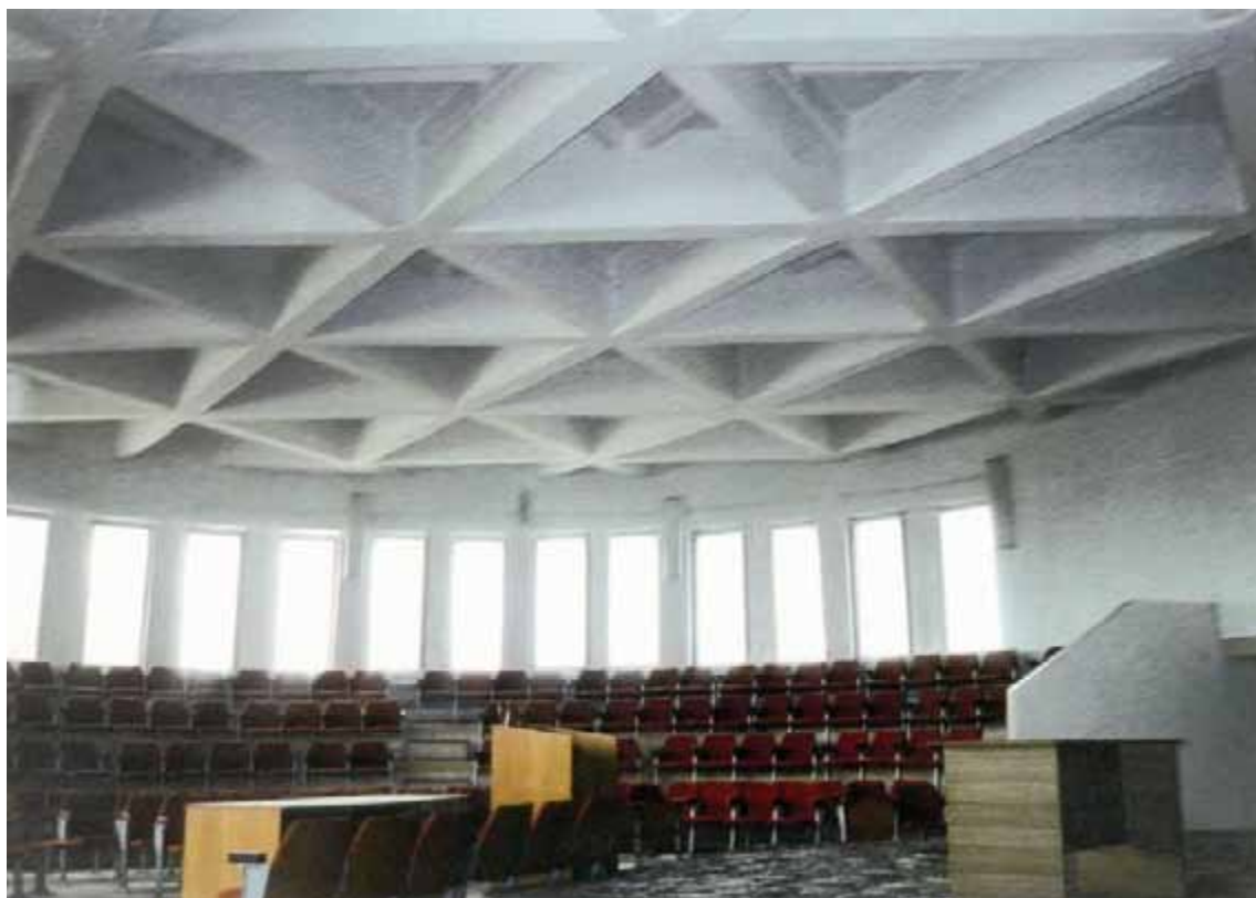
Рис. 17. Збірно монолітне кесонне перекриття актового залу круглої форми діаметром 18,4 м (м. Ужгород, завод електродвигунів)
