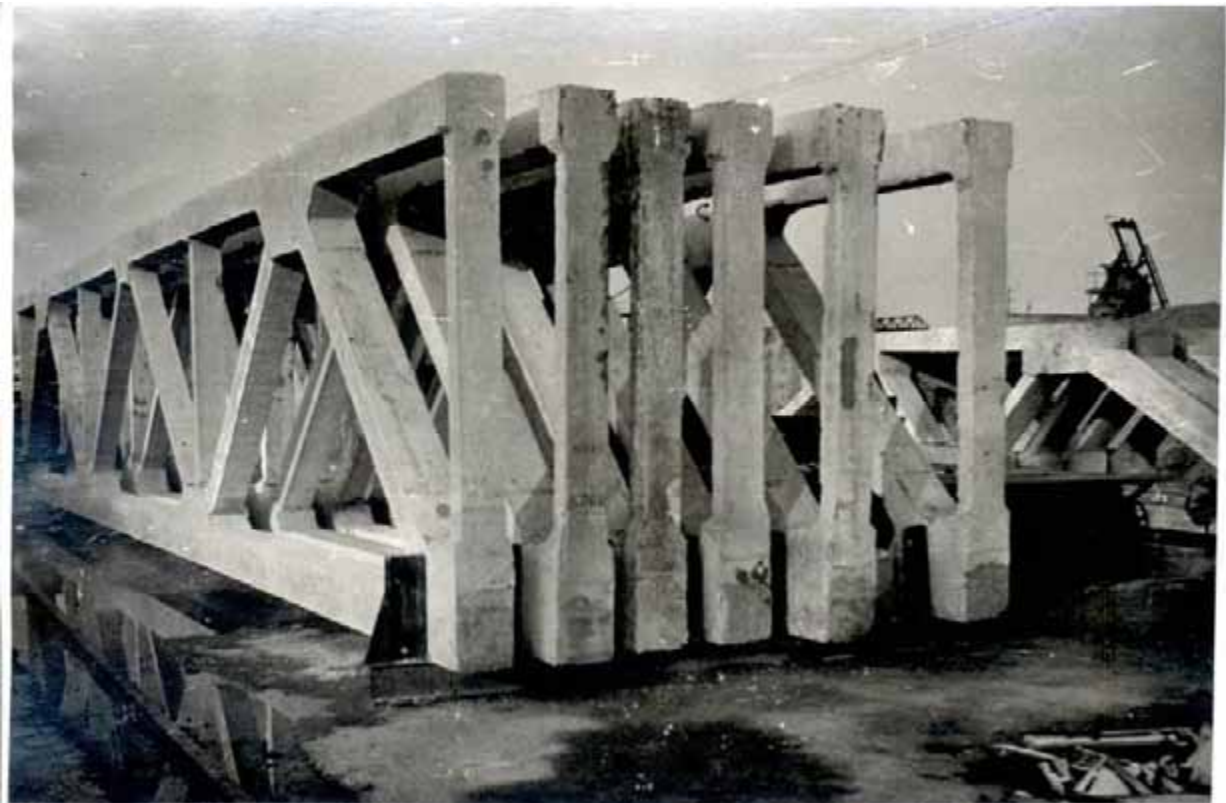
Рис. 7. Ферми з паралельними поясами довжиною 18,0 м і підкрокв'яні ферми довжиною 12,0 м, виготовлені на заводі ЗБК №1
