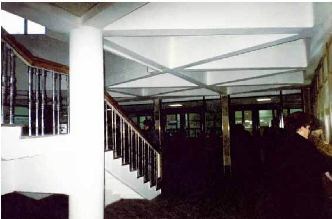
Рис. 20б. ЗМКП цокольного поверху непрямокутної форми для великих навантажень (м. Львів, стилобат адміністративного будинку на вул. Стрийській)
