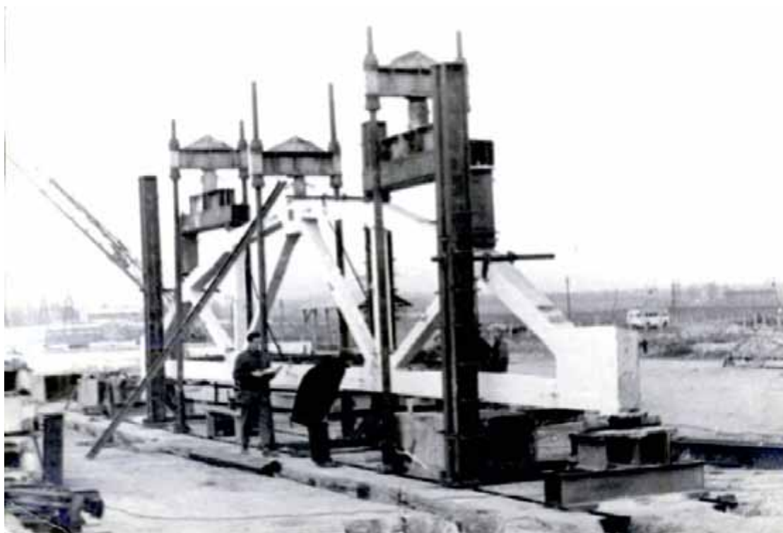
Рис. 10. Випробування сегментної ферми довжиною 18,0 м на заводі ЗБК №2 в м. Львові
