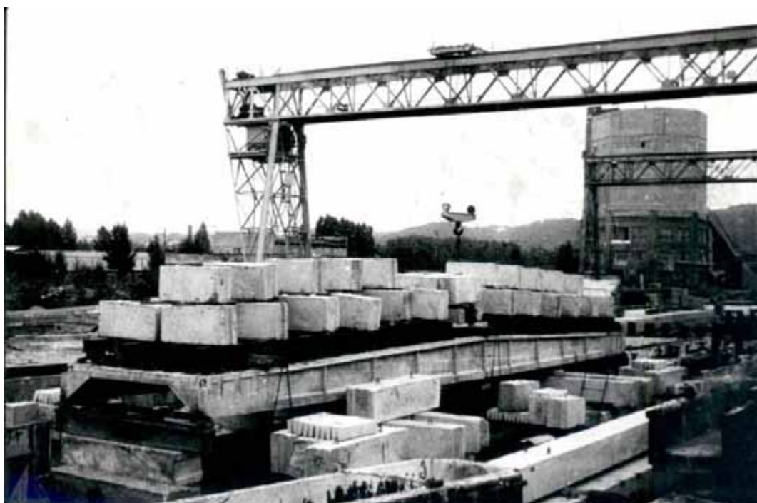
Рис. 11. Випробування великорозмірних ребристих плит покриття розмірами 3 × 18 м на проліт на полігоні заводу ЗБК №2 в м. Львові
