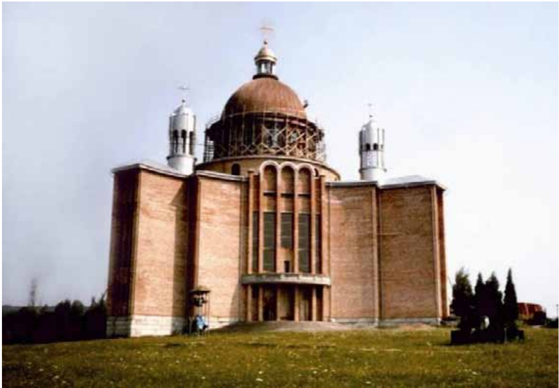
Рис. 24. Загальний вигляд церкви Різдва Богородиці в м. Новий Розділ із застосуванням збірно-монолітного залізобетонного купола діаметром 15 м
