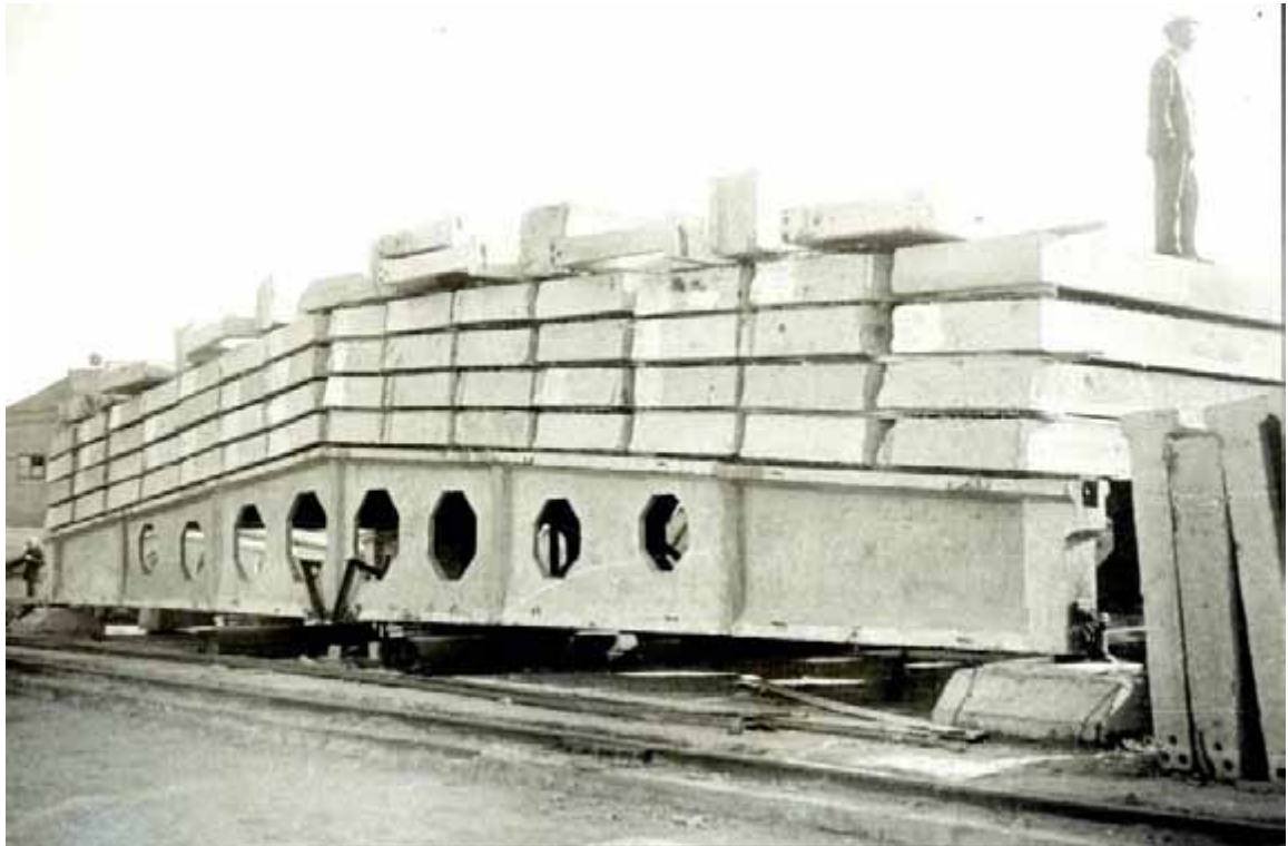
Рис. 1. Випробування складених балок покрить типу БНСД-18 на будівництві заводу залізобетонних конструкцій №2 в м. Львові (1958 р.)
