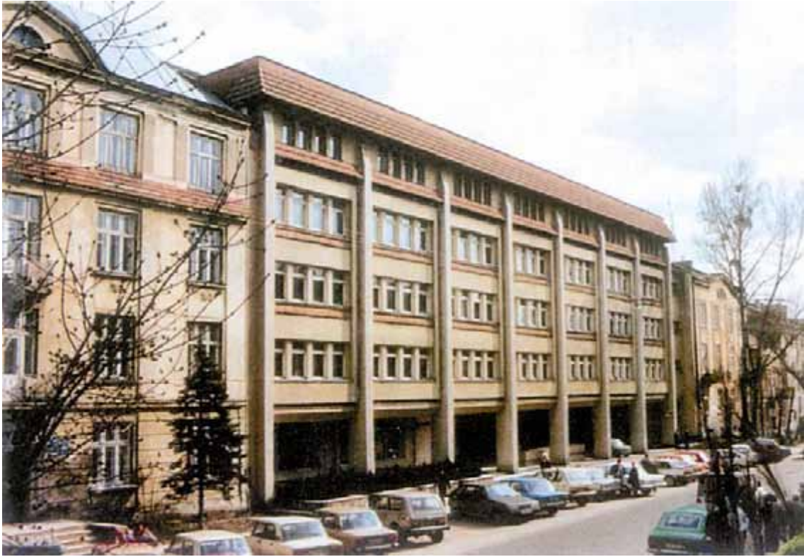
Рис. 16а. Будинок інституту “Містопроект” з кесонних перекриттів розмірами 18 × 24 м (м. Львів, спортивний і актовий зали)
