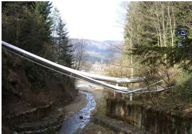
Просідання ґрунтів та пластичне деформування оболонкових конструкцій – важливі чинники в оцінці несівної здатності магістральних трубопроводів
