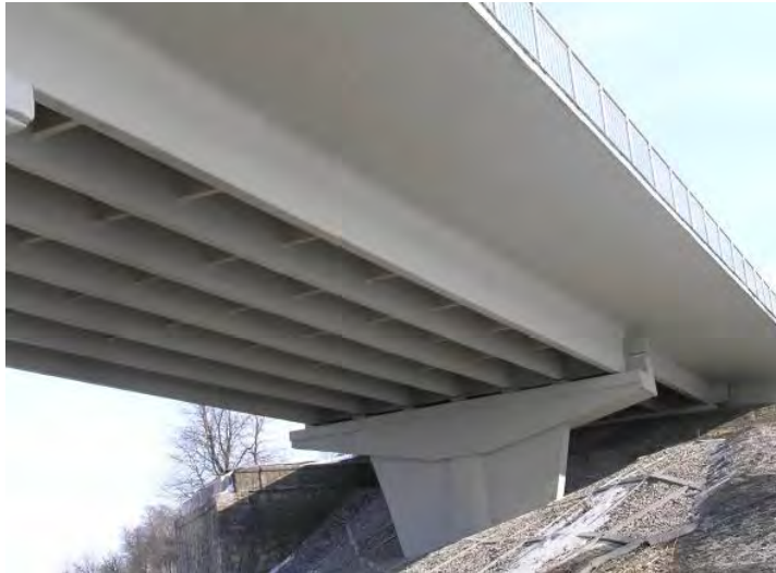
Фото 6. Лабораторні і натурні дослідження дозволили вперше в Україні підсилити композитами прольотні будови шляхопроводу в с. Вістова, Івано-Франківської обл. та моста через р. Уж на км 149 автомобільної дороги Київ–Ковель–Ягодин, Житомирської обл.
