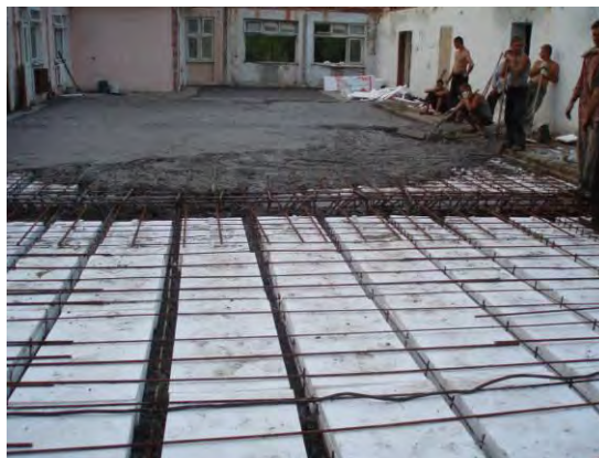
Фото 7. Фрагменти конструкції і улаштування перекриттів з ефективними вставками
