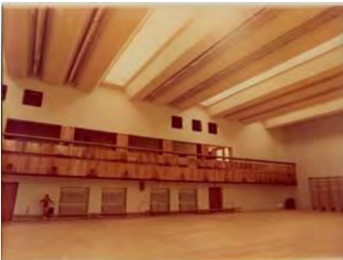
Фото 2. Покриття спортивного залу Центру творчості дітей та юнацтва Галичини виконане з пустотних складчастих настилів прольотом 18 м з трикутними світловими ліхтарями
