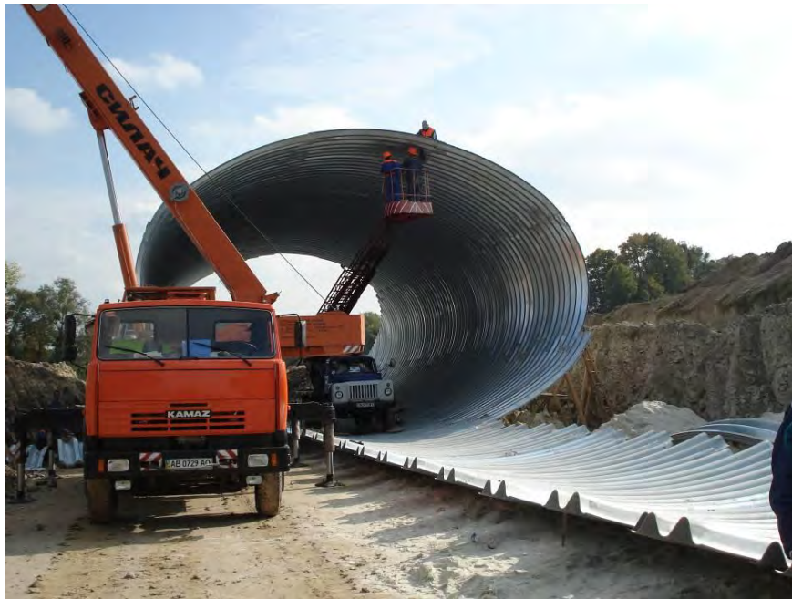
Рис. 5. Монтаж металевої труби на автомобільній дорозі Київ–Львів
