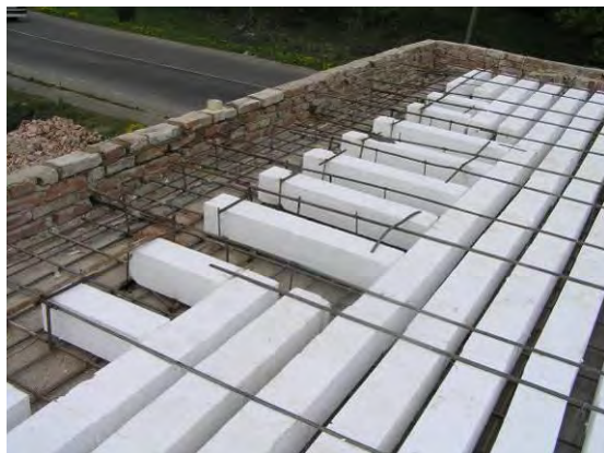
Фото 7. Фрагменти конструкції і улаштування перекриттів з ефективними вставками
