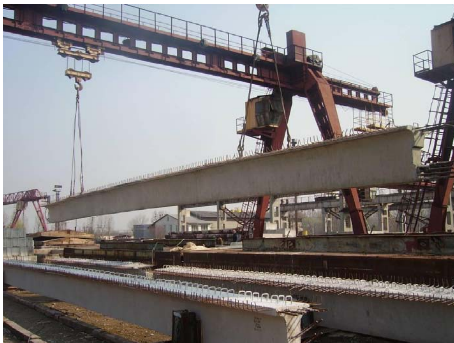
Фото 3. Мостові балки завдовжки 24,0 м виготовлені на полігоні ВАТ ЛЗЗБВ №2
