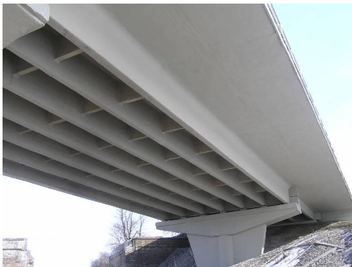
Рис. 5. Загальний вигляд шляхопроводу після реконструкції
