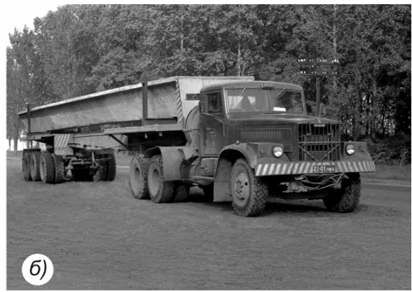
Фото 9. Транспортування конструкцій: а, б – завантаження та перевезення пустотного складчастого настилу прольотом 18 м
