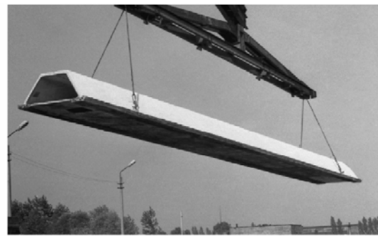
Фото 2. Пустотна складчаста панель
