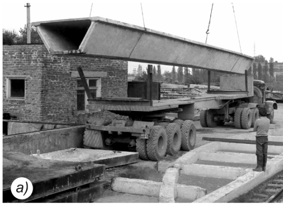
Фото 9. Транспортування конструкцій: а, б – завантаження та перевезення пустотного складчастого настилу прольотом 18 м
