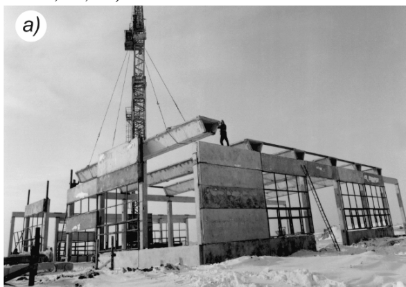
Фото 10. Покриття головного корпусу гаража: а – на стадії монтажу; б – вигляд усередині приміщення
