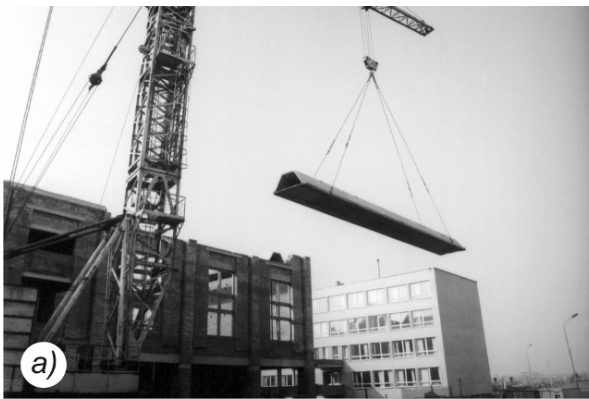
Фото 12. Покриття спортзалу технікуму МОД: а – на стадії монтажу; б – вигляд усередині приміщення
