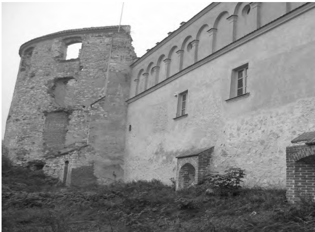
Rys. 3. Elewacja północna Zamku w Janowcu. Miejsce pobrania kamienia K3 [1]
