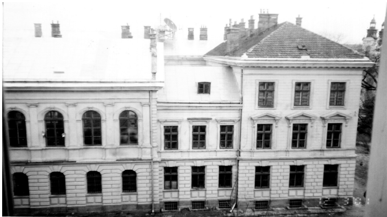
Корпус Національного університету "Львівська політехніка". Фото 2001 р.
