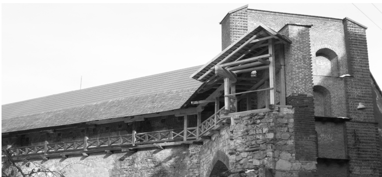
Рис. 6. Керамічна дахівка на будівлі Міського арсеналу у Львові. Процес виконання робіт
