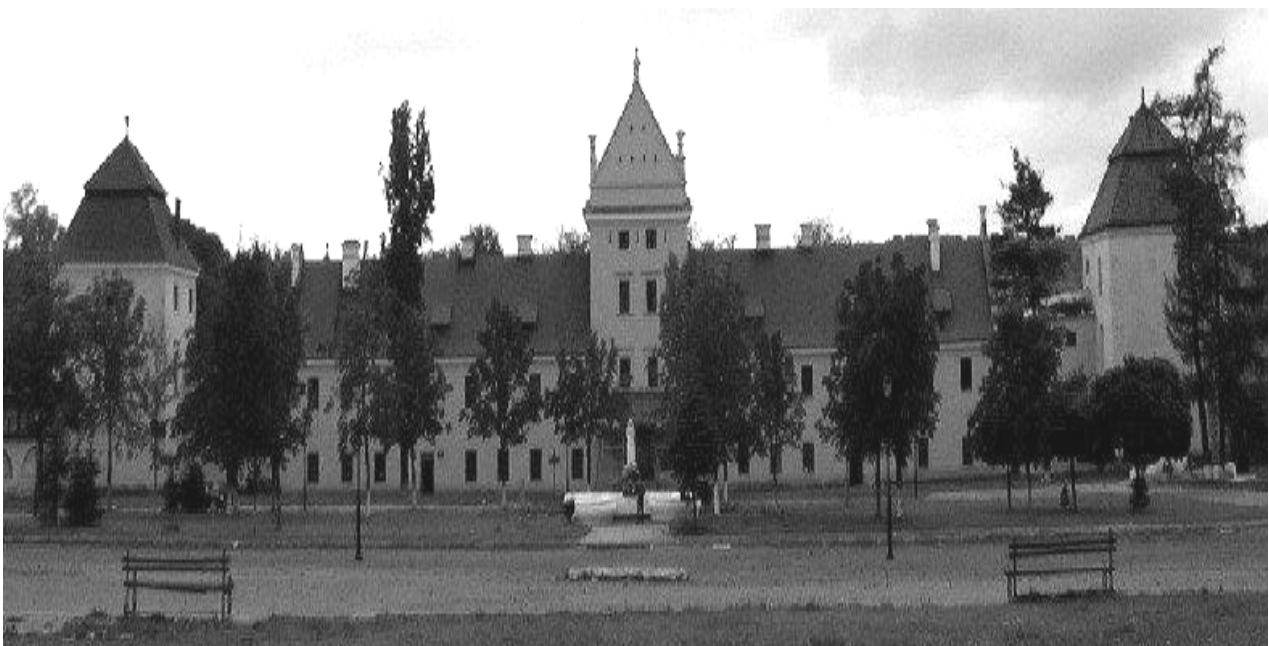
Рис. 2. Замок кінця XVI ст. у Жовкві. Реставраційні роботи 2006, 2007 р. Відновлено покриття з керамічної дахівки
