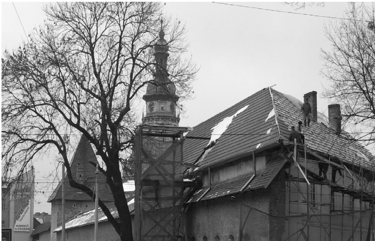
Рис. 10. Заміна дахівки на будинку управління охорони історичного середовища Львова
