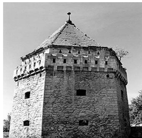
Рис. 4. Вежа замку в м. Скалат: покрівля з дахівки поч. XX ст., сучасний стан
