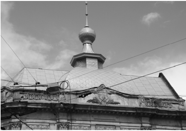
Рис. 5. Приклад нереставраційного ремонту даху будівлі-пам'ятки на вул. Гнатюка у м. Львові. Застосовано невластивий для історичної будівлі матеріал, при заміні покрівлі спрощено відтворено низку деталей і профілювань, частину старого металевого декору втрачено. Приклад некомплексного підходу до проведення робіт на пам'ятці архітектури. Реставраційний ремонт покрівлі мав би супроводжуватися реставрацією карнизів та декоративних парпетів
