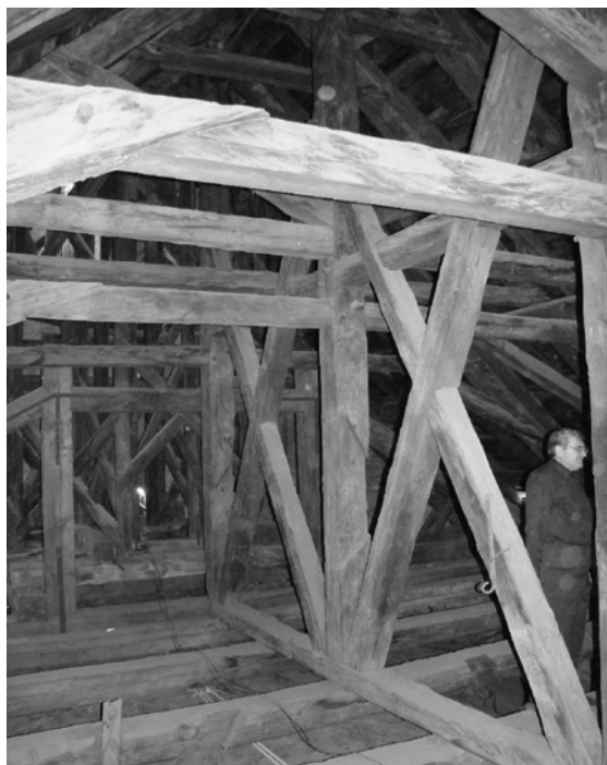
Рис. 8. Добре збережена автентична дерев'яна дахова конструкція колишнього костелу Св. Казимира у Львові (а); Приклад "ремонту" даху на будівлі-пам'ятці на проспекті Т. Шевченка у Львові (б)
