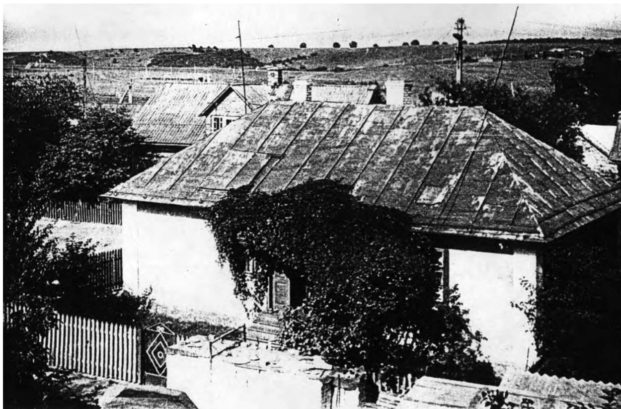
Рис. 7. Варяж. Будинок з шалашем у даху. Вул. Низова, 3 (сьогодні шалаш розібрано, стан 1995 р.)
