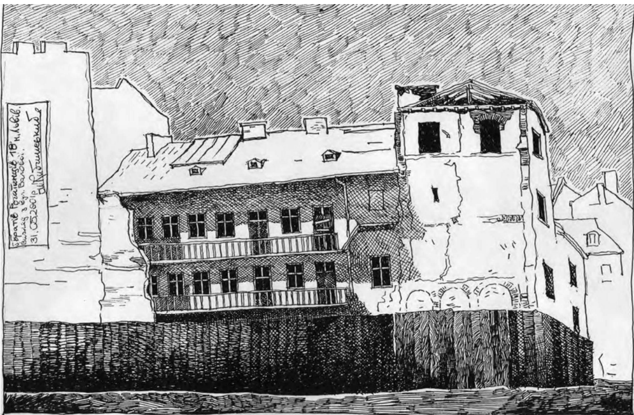
Рис. 2. Львів. Будинок з шалашем у даху. Вул. Братів Рогатинців, 18 (сьогодні будинок перебудований, шалаш втрачений, стан з 2001 р.)
