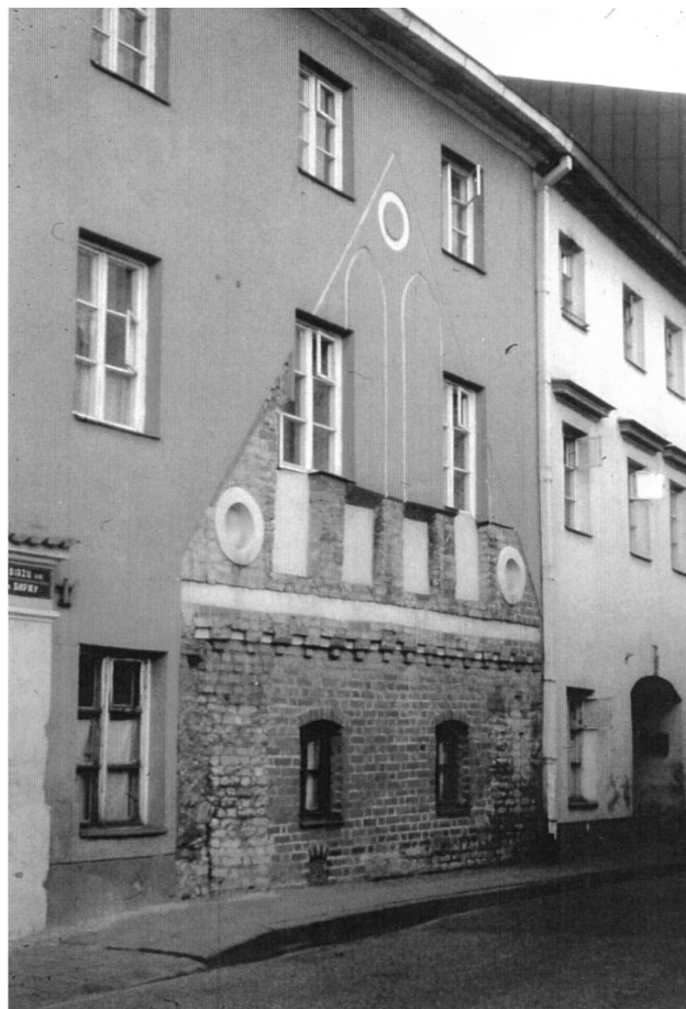
Рис. 5. Вільнюс, вул. Біржи, 3. Приклад консервації фасаду кам'яниці, в якій відкрито партерний дім з готичним щитом; фото М. Бриковської, 1995 р.
