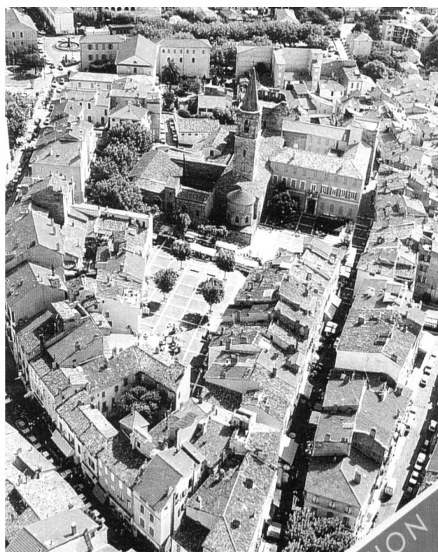
Рис. 7. Фреюс, Франція, вигляд старого центру міста після ревалоризації. Фото за "Rehabilitation du Centre Ancien"
