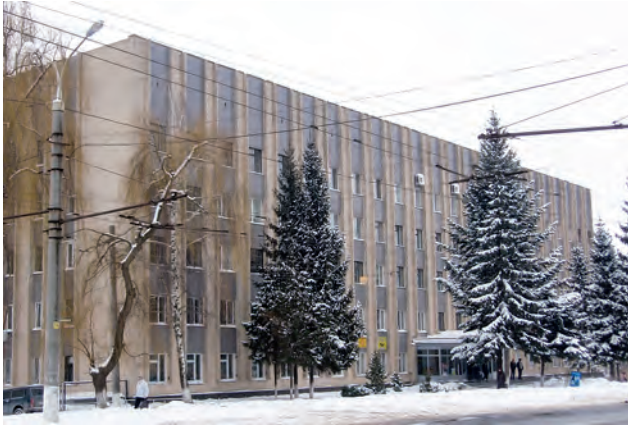
Адміністративна будівля ДП "Подільлягеодезкартографія"
