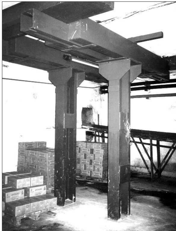
Рис. 3. Загальний вигляд колон і балок після реконструкції
