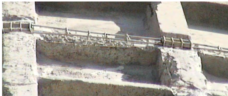
Рис. 8. Елемент підсилення напруженою арматурою між закладними деталями стикування панелей
