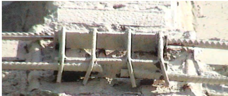
Рис. 7. Анкерування кільцевої напруженої арматури на підсилені закладних деталях панелей
