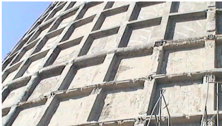
Рис. 9. Підсилені горизонтальні ребра плит оболонки з включеною в роботу кільцевою арматурою (під час виконання захисту напруженої арматури від корозії)
