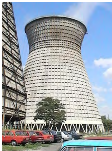
Рис. 1. Збірна ребриста біконічна градирня після ремонту оболонки
