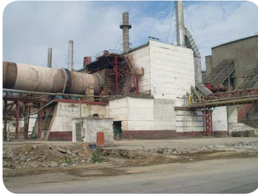
Дарницька ТЕЦ, збірна залізобетонна біконічна градирня ст. № 4, м. Київ.
