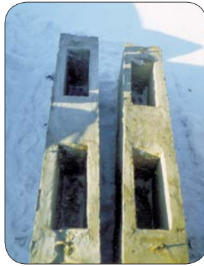
Плоскі монолітні залізобетонні перекриття з ефективними вставками
