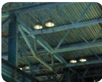
Двоконсольне сталезалізобетонне перекриття l = 18 м
